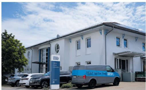
Durch die Zusammenführung entsteht ein leistungsstarkes Kompetenzzentrum für Werkstofftechnik, industrielle Analytik und Qualitätssicherung.
